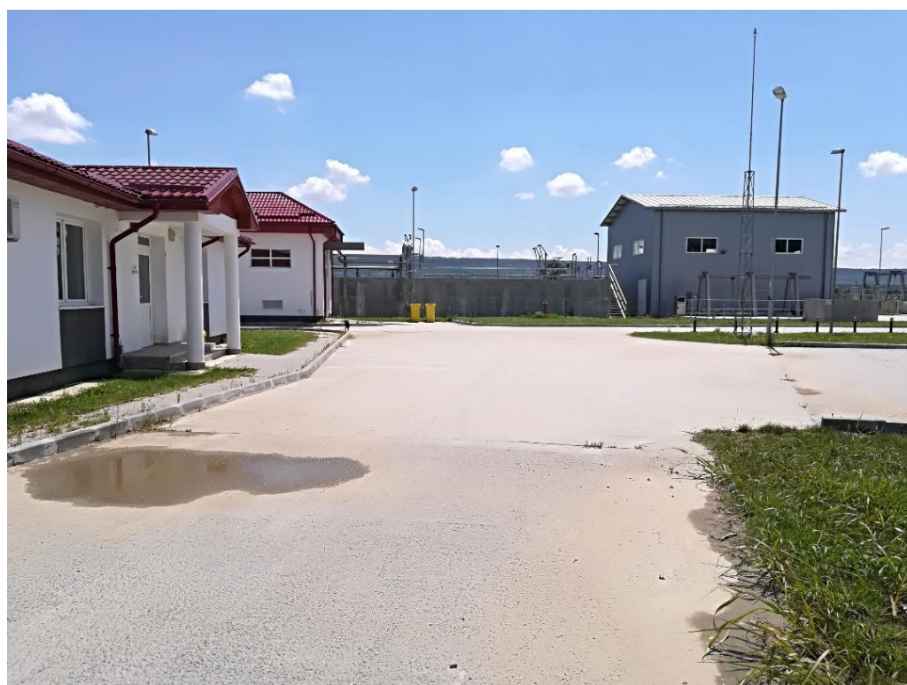
STATIE EPURARE BECHET
