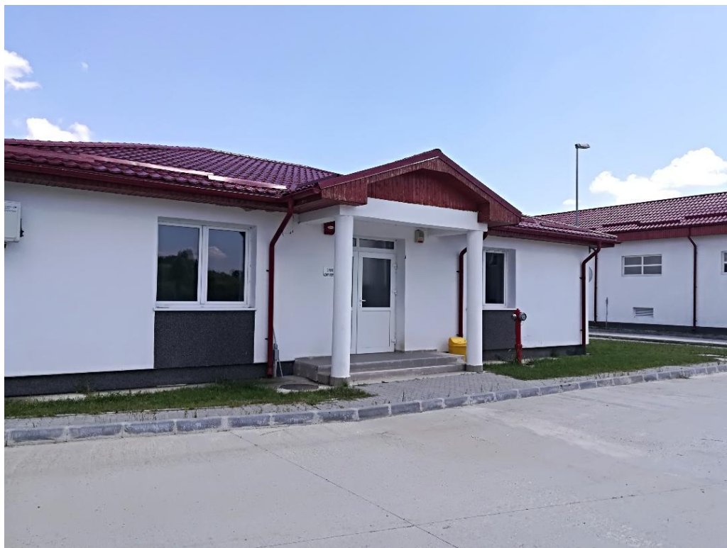
STATIE EPURARE BECHET
